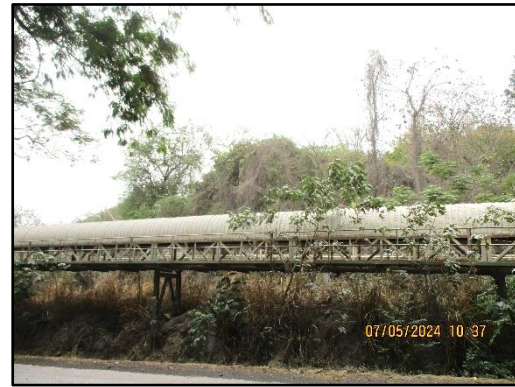
ภาพที่ 2.19 สายพานลำเลียงหินเป็นแบบปิด
