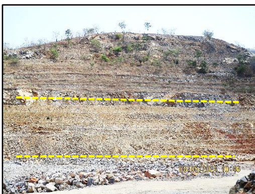
ภาพที่ 2.8 การนำเศษหินและเศษดินทำคันดินสำหรับปลูกต้นไม้บริเวณพื้นที่ที่ผ่านการทำเหมือง
