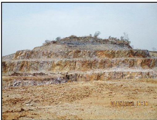
ภาพที่ 2.7 การเปิดหน้าเหมืองแบบขั้นบันได
