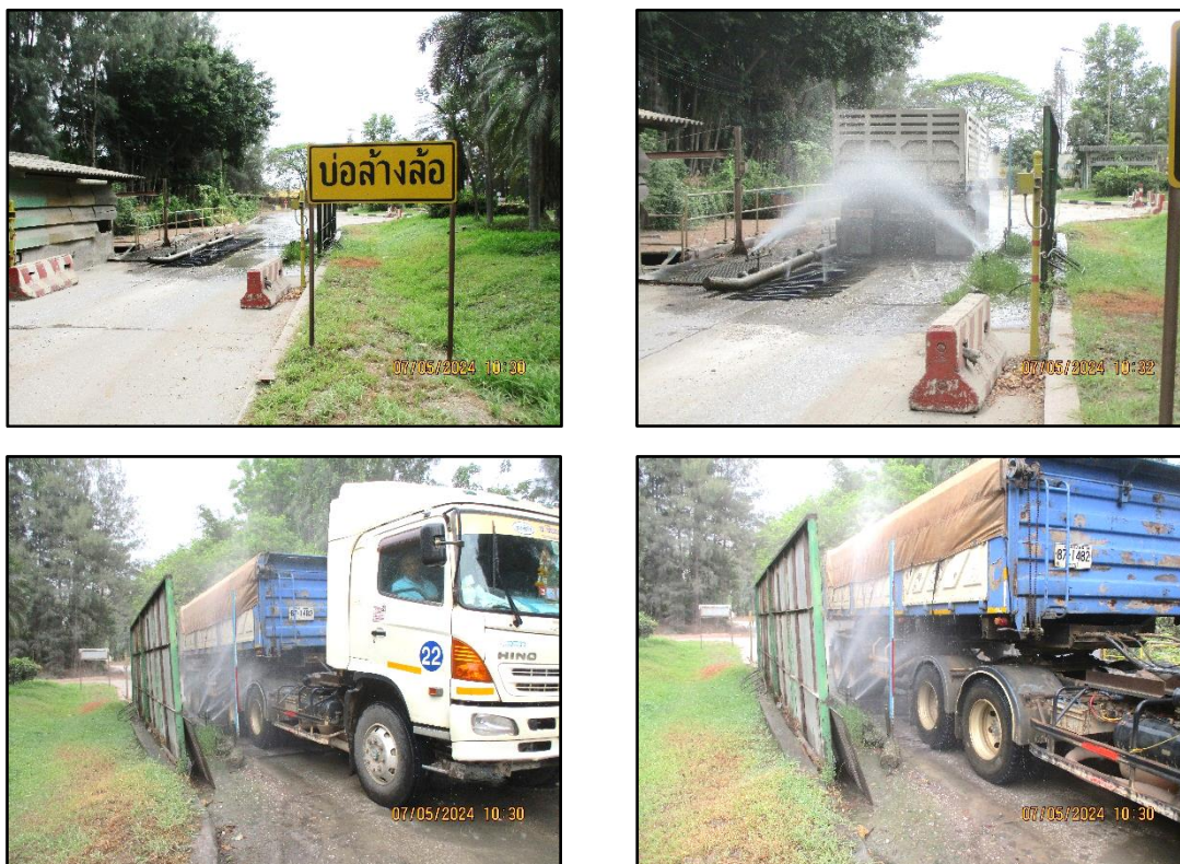
ภาพที่ 2.18 จุดล้างล้อและทำความสะอาดบรรทุกทุกและรถต่างๆ
